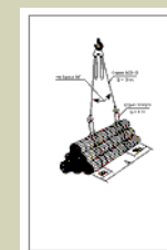
Арматурные сетки в рулонах при разгрузке
