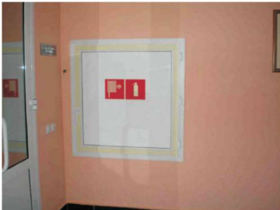
Рисунок А.6. Обозначение фотолюминесцентной 50-мм лентой
